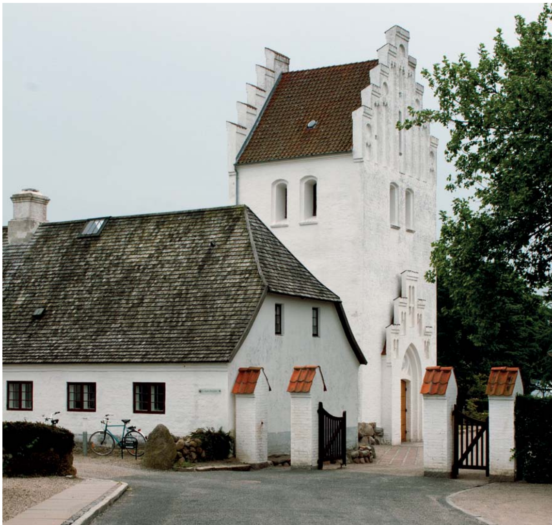
Fig. 6. Kirken og hospitalet set fra nordvest. Foto Mogens Vedsø 2012. – The church and the hospital seen from the north west.
