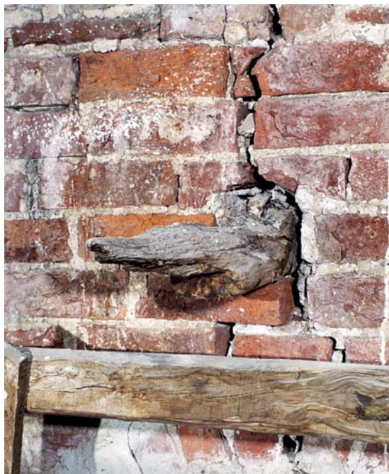
Fig. 56. Udsnit af vestforlængelsens trekantgavl (s. 412) med muranker set fra loftet. Foto Arnold Mikkelsen 2011. – Part of the inner west gable of the church.
